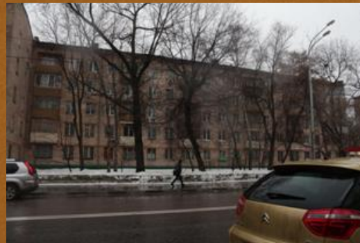
Дом №9, 5 этажей, кирпичный, 1963 года
